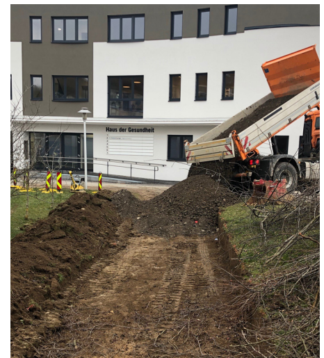
Foto (Gemeinde): Bau des Gehweges
